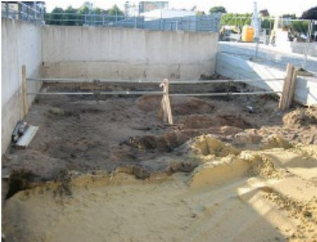
Auf der 144 m<sup>2</sup> großen Fläche wurden 279 m<sup>3</sup> belastetes Erdreich entsorgt und gegen Füllsand ausgetauscht.
